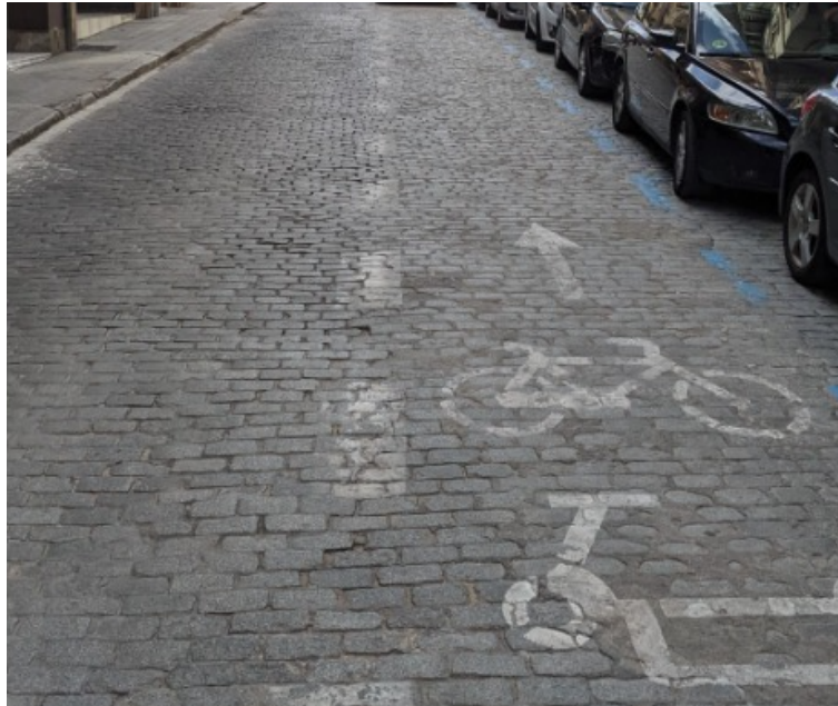
Simulación de delimitación de vía ciclista y ejemplo de SRB -Sentido Reservado Bicicletas- en Segovia
