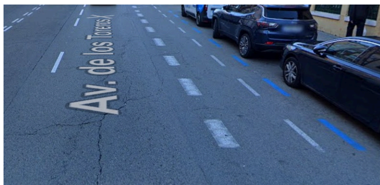
Carril bici unidireccional segregado sin separadores
