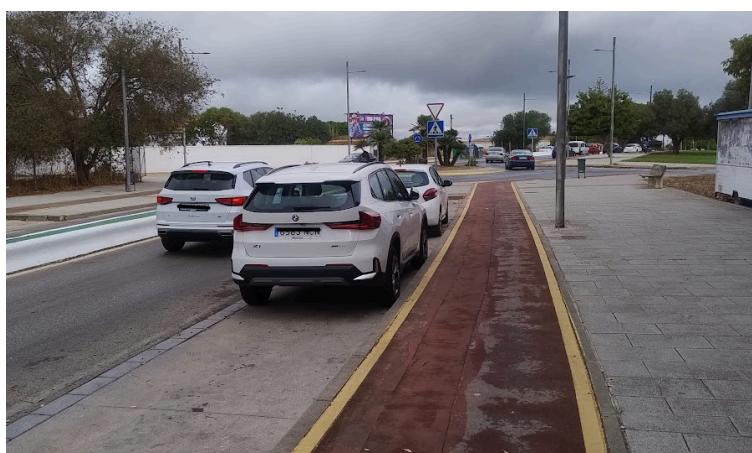
Detalle anchura y potencial afectación por puertas en acera bici de lado sur de la Av. Constitución
