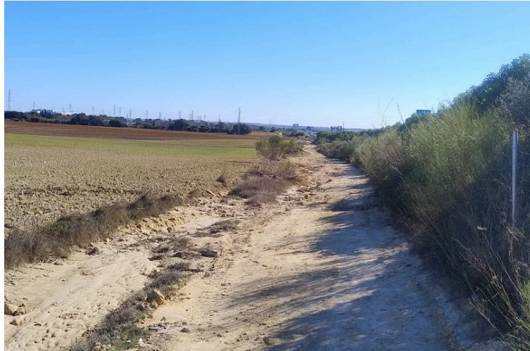
Estado de la plataforma del camino paralelo a la A-4
