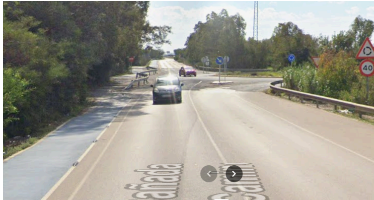
Tramo final de carril bici junto rotonda acceso a A-4
