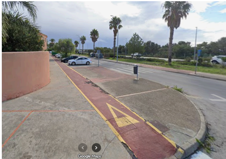
Acera bici en su confluencia con cruce, véase anchura y afectación por parking en batería
