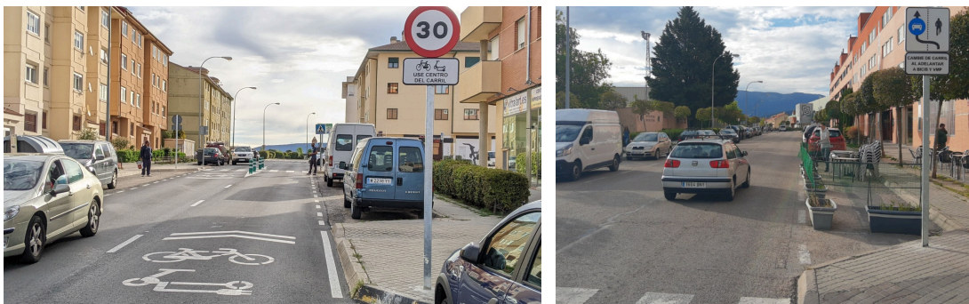
Ejemplos de señalización horizontal y vertical en ciclocarriles, en Segovia
