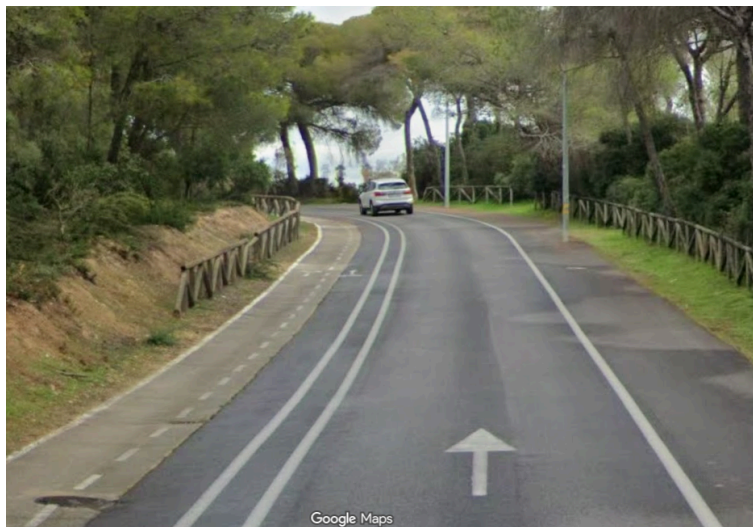
Carril bici bidireccional con resguardo obtenido con obra de asfaltado de nivelación con la acera peatonal existente previamente. Nótese la diferencia de pavimento
