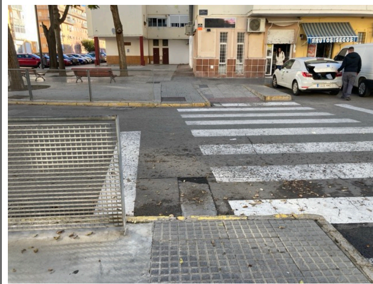
Paso de cebra sin visibilidad debido a la presencia de aparcamiento en batería.
