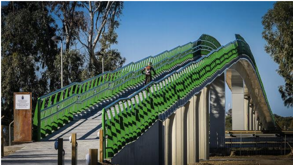
Figura 46. Pasarela de Las Aletas sobre la Autovía CA-32.
