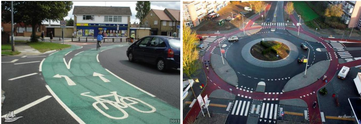
Figura 79. Buenas prácticas de glorietas ciclables en Reino Unido (izda.) y Holanda (dcha.).
