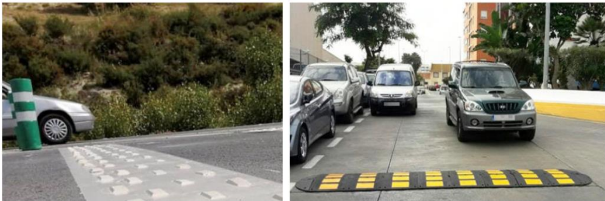
Figura 134. Speed Humps y Bandas Transversales de Alerta (BTA).
