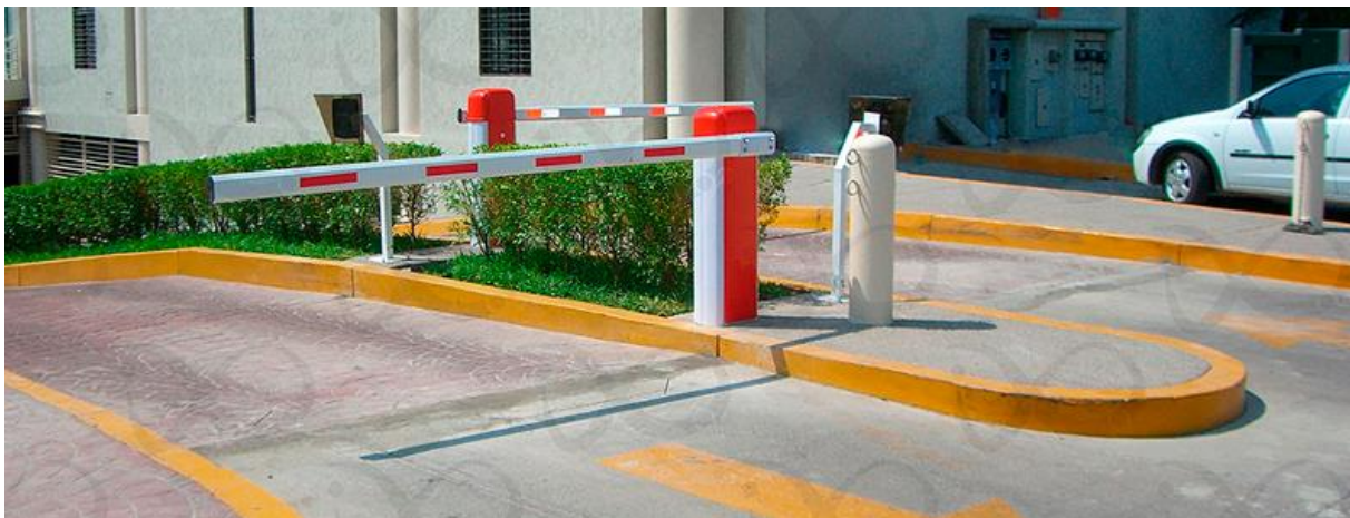
Figura 150. Control de acceso mediante barreras.
