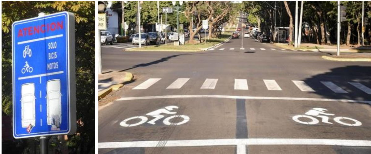
Figura 106. Ejemplo de cruce semaforizado con zona adelantada para la espera de motos.
