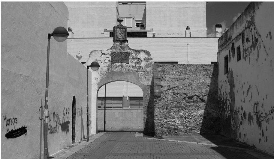
Figura 7. Frente del Arco de San Miguel previo a los trabajos de restauración, junio 2019
