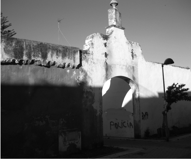
Figura 8. Trasera del Arco de San Miguel, previo a los trabajos de restauración, junio 2019.
