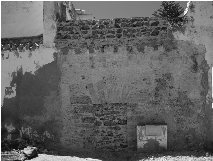
Figura 5. Parte trasera del arco adintelado
