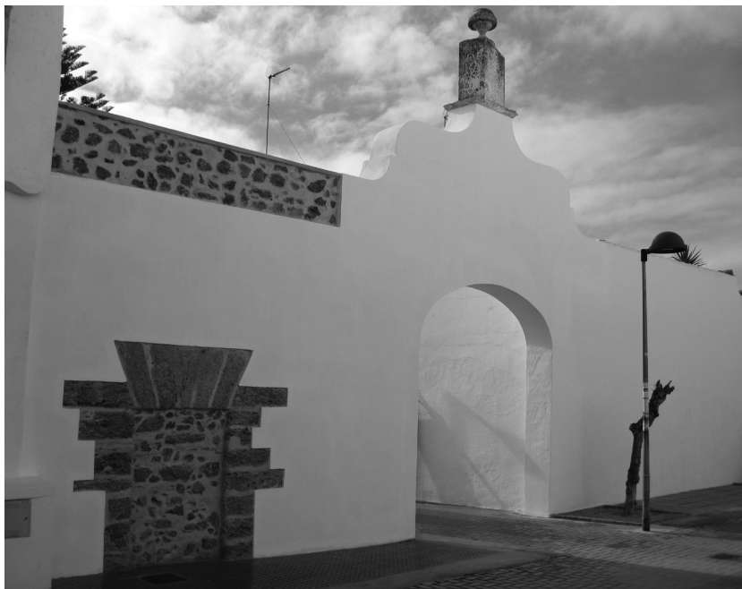
Figura 10. Arco de San Miguel, tras los trabajos de restauración. Vista desde calle San Miguel.
