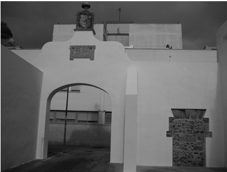
Figura 9. Arco de San Miguel, tras los trabajos de restauración. Vista desde calle San José
